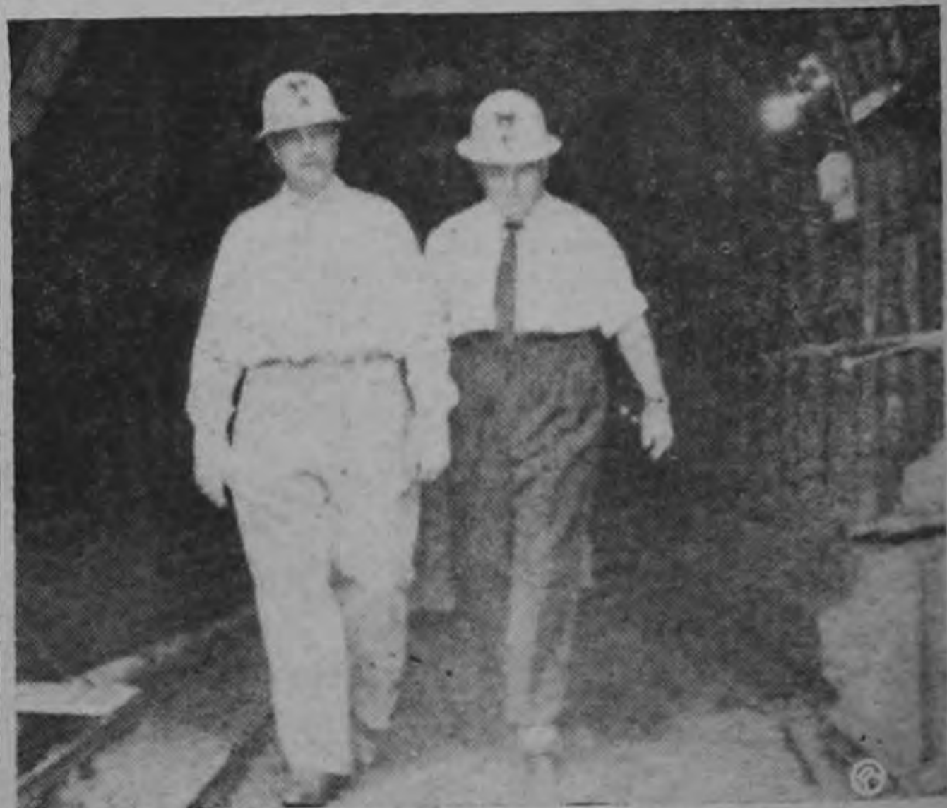
EN UN TUNEL DE LA GARITA.—Los Cancelleres Mendoza, de Honduras y Esquivel, de Costa Rica, atravesando uno de los túneles de La Garita, durante la visita a esta Planta Hidroeléctrica, que ayer se celebró en homenaje al Dr. Mendoza (Foto Solano).
